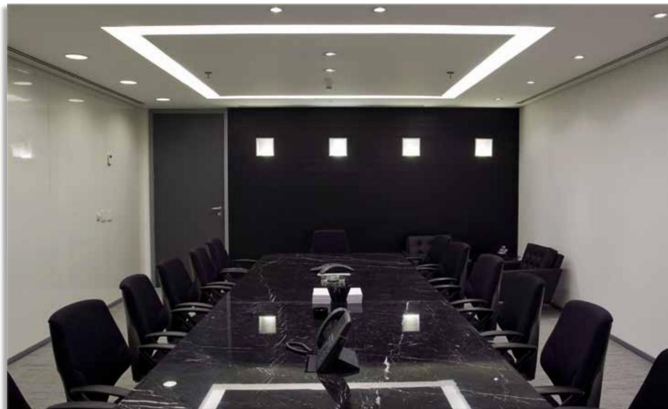
ro, que foram substituídos por pendentes com fluorescentes tubulares T5 de 28W e temperatura de cor de 3000K no centro da mesa. Estas soluções proporcionam iluminação indireta, por meio de um difusor em acrílico translúcido, e direta, através de refletor e aletas duplo parabólicas de alumínio anodizado.
