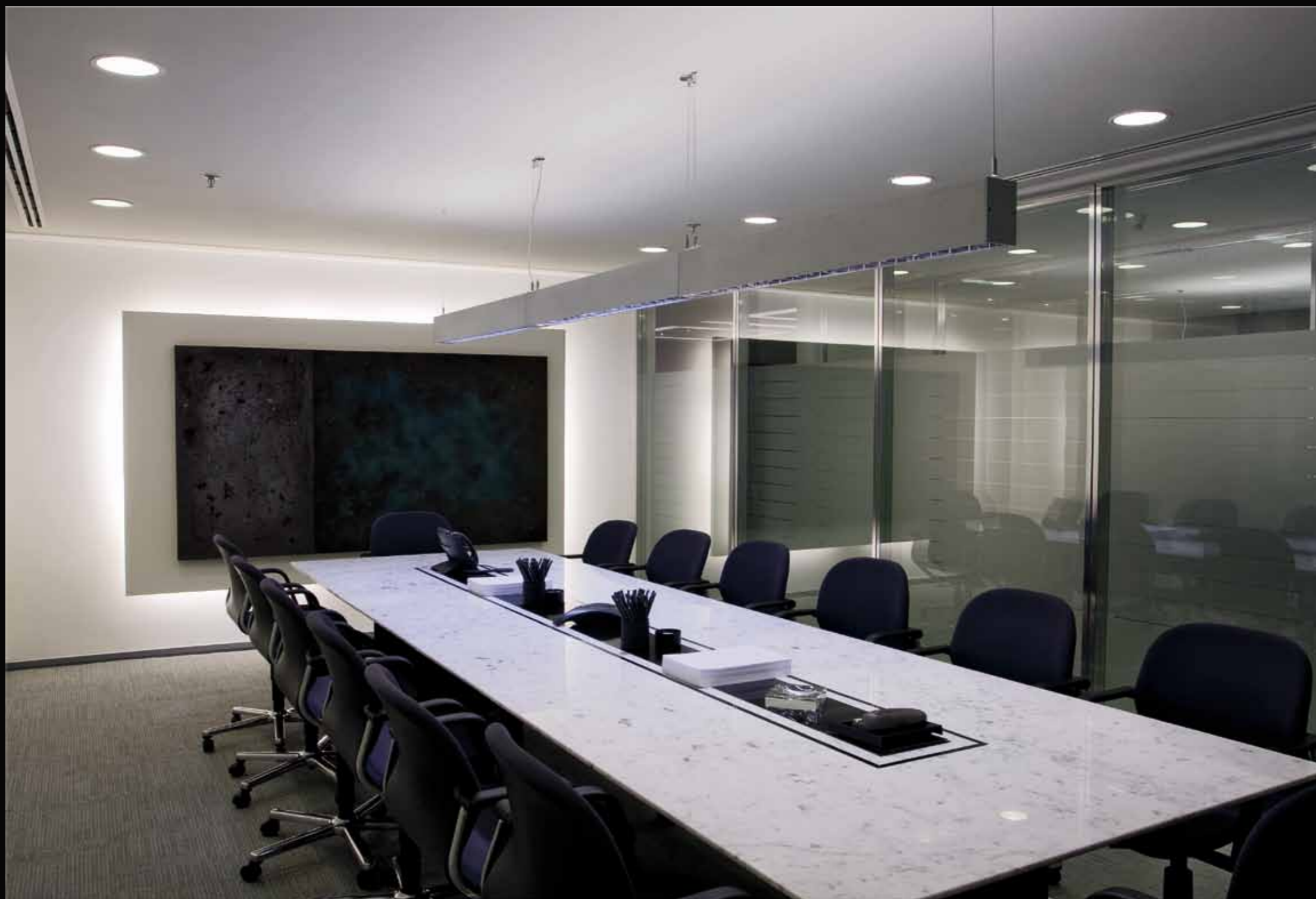
Mesa da sala de reuniões menor iluminada por pendente com fluorescentes tubulares T5 de 28W e temperatura de cor de 3000K.
