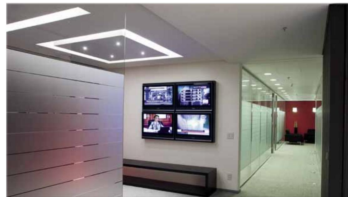
Lounge iluminado por fluorescentes tubulares T5 de 28W, IRC de 85 e 3000K instaladas em rasgos no forro de gesso formando quadrados e embutidos com halógena PAR 20 de 50W e 30°.
