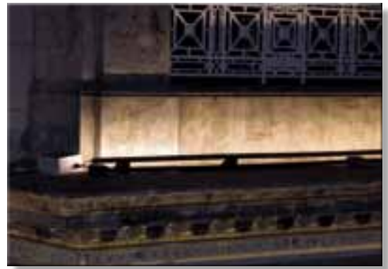
À esquerda, cimalha superior com fluorescente T5 de 28W e 3000K e vitral iluminado de dentro pra fora. Acima, caixa blindada aloja as fontes das fitas de LEDs, que possuem IP 20.
