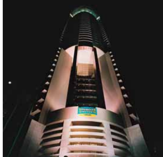
Os grandes pilares que se encontram nas fachadas frontais receberam um uplight com tonalidade de cor mais branca, por causa do revestimento.
