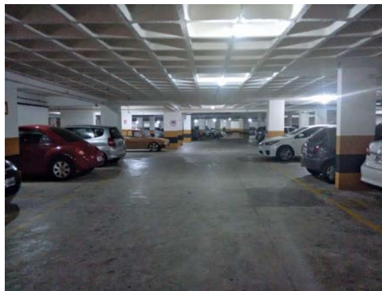
Figura 9 - Iluminação do pavimento E1.
