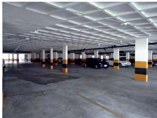
Figura 2 - Visão parcial do pavimento E2.
