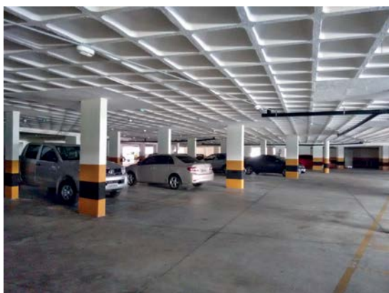
Figura 1 - Visão parcial do pavimento E1.
