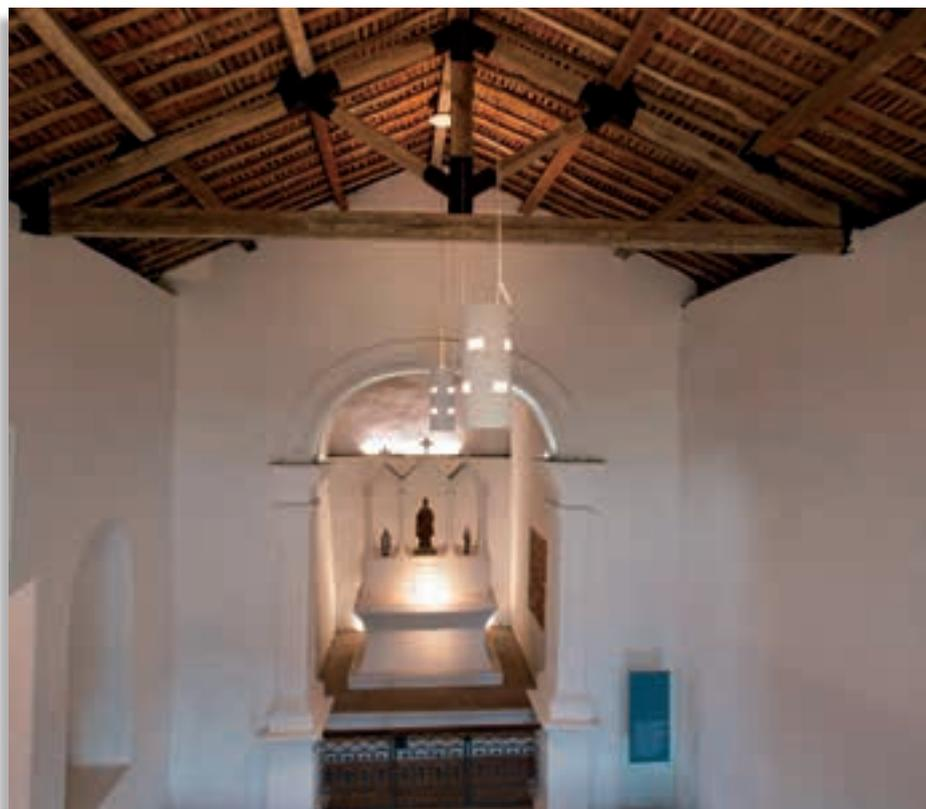
Para iluminar tanto a nave como o telhado original da capela, optou-se por luminária técnica cilíndrica, fixadas no madeiramento, com PAR 30 LED a 3000K.
