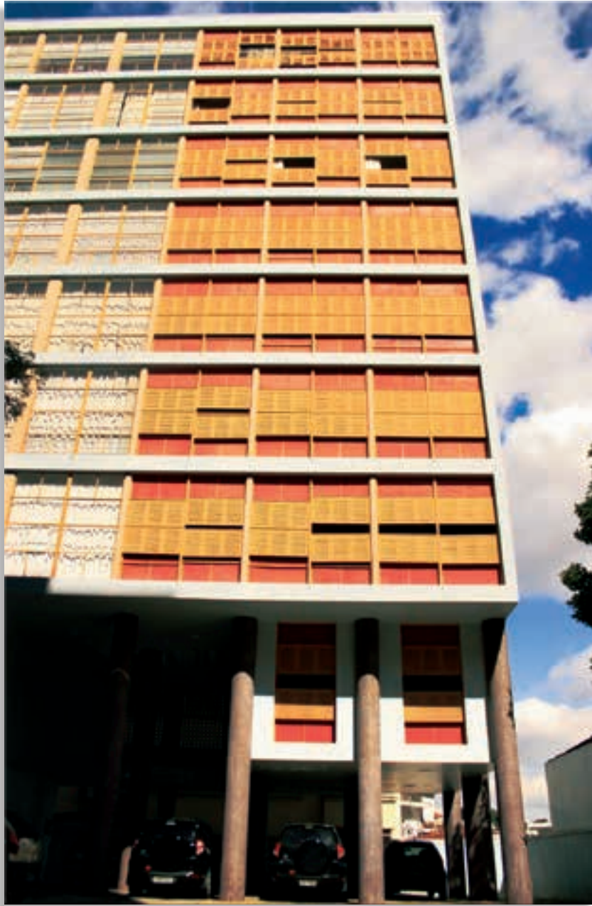
Edifício Louveira (1946) Fonte: Mariana Sato (Jul. 2013)
