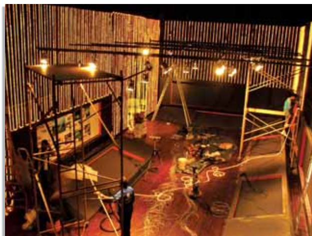
Montagem dos painéis e do sistema de iluminação da exposição MOVA Arquitetura.
