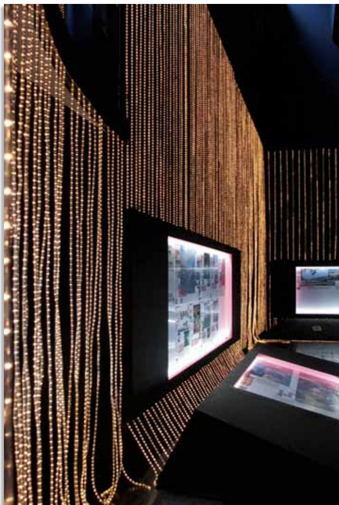
Mangueiras luminosas com lâmpadas incandescentes de 0,5W foram instaladas em toda a parede da exposição.
