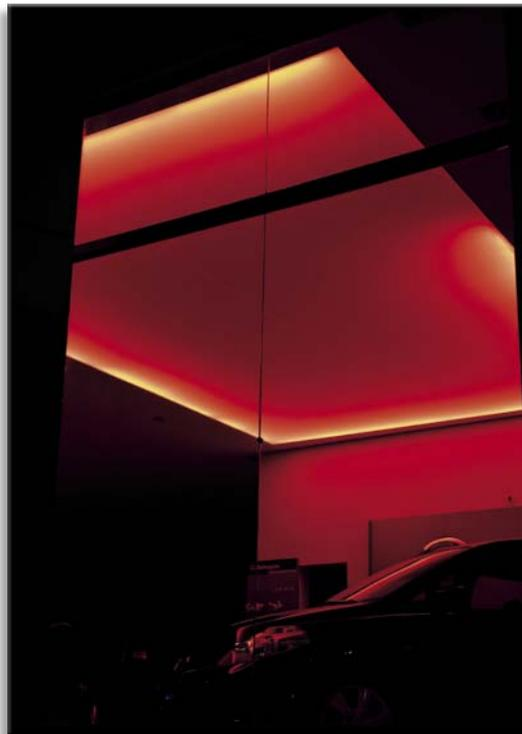
Grande tela de lona tensionada equipada com 24 fluorescentes T5 de 54W a 3000K e 24 fluorescentes T8 de 24W com filtro corretivo vermelho destaca a entrada da Nissan Bandeirantes.
