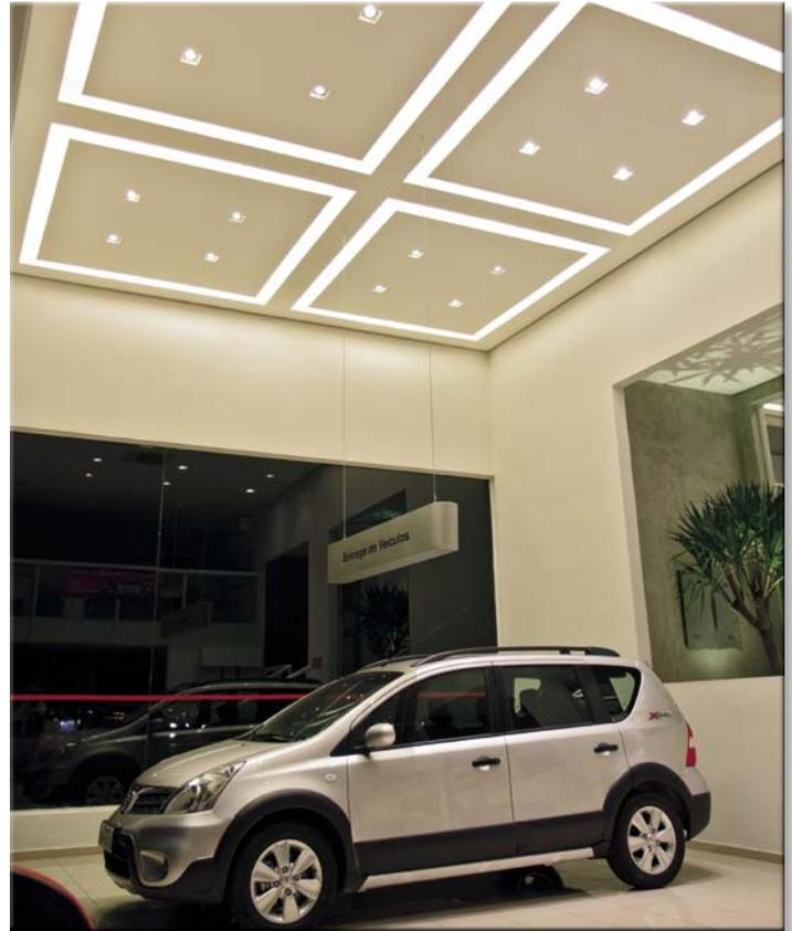
T5 de 54W a 3000K, atingindo 450 lux sem precisar de luminárias aletadas. Na sala do gerente foram desenvolvidos quatro grandes quadrados no teto com a mesma solução. Nos banheiros também optou-se pelos rasgos no forro, mas com fluorescentes T8 de 36W a 3000K. Apenas os locais destinados a deficientes receberam luminárias orientáveis embutidas no teto com lâmpadas dicroicas de 50W.
