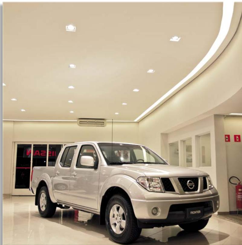
Intercalados com luminárias de gesso, no forro, com fluorescentes, há rasgos pintados de preto equipados com luminárias embutidas orientáveis para uma lâmpada PAR 30 de 70W. “Trabalhamos com luz pontual e focos variados de 10° e 40°. Como o layout dos carros muda continuamente, conseguimos banhar os carros com os focos de 40° e dar destaque em pontos deles com os de 10°”, explicou Serradura. A luminosidade na área do showroom varia entre 400 a 600 lux, com a luz difusa e pontual.
