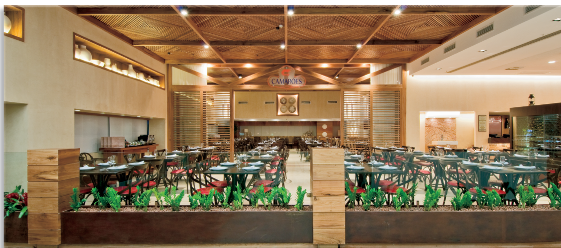
À esquerda, forro de madeira recebeu luminárias de sobrepor com lâmpada refletora CDMR PAR 30 de 35W/30° a 3000K.
