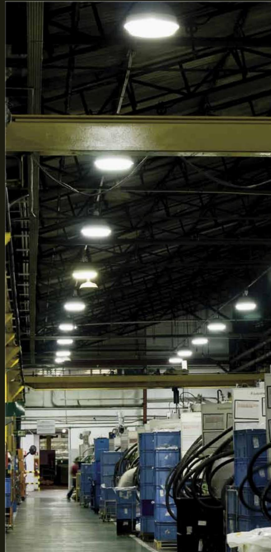
conforme a necessidade de cada local, orçamento e disponibilidade do espaço para a realização dos serviços – já foram substituídas 426 lâmpadas. Lâmpadas de vapor metálico de 400W, de vapor de sódio de 400W, mistas de 250W e HOs de 110W deram lugar a lâmpadas de vapor metálico mais modernas, de 400W e 200W, com fluxo luminoso de 44 mil e 20 mil lumens, respectivamente, e IRC de 70. Os vários tipos de lâmpadas anteriormente instalados eram herança de projetos de diferentes datas e filosofias.
