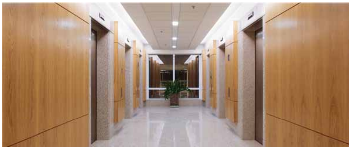
Nos halls dos elevadores, sancas invertidas fornecem luz geral indireta para todo o espaço. No eixo central do teto, rebaixamento do forro escondeu os dutos de ar e abrigou luminárias de embutir.
