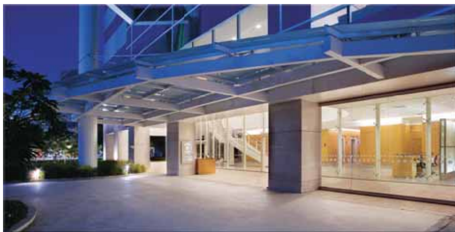
Fachada principal do edifício. Iluminação apenas nos pilares laterais, para evitar interferências nos feixes de luz da torre.
