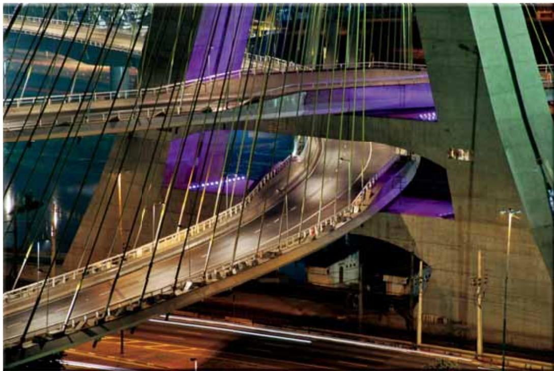
Túnel, como é chamado o encontro dos dois tabuleiros com o mastro, recebeu projetores com LEDs com fecho aberto na altura da pista da inferior, para compensar o pé-direito baixo.
