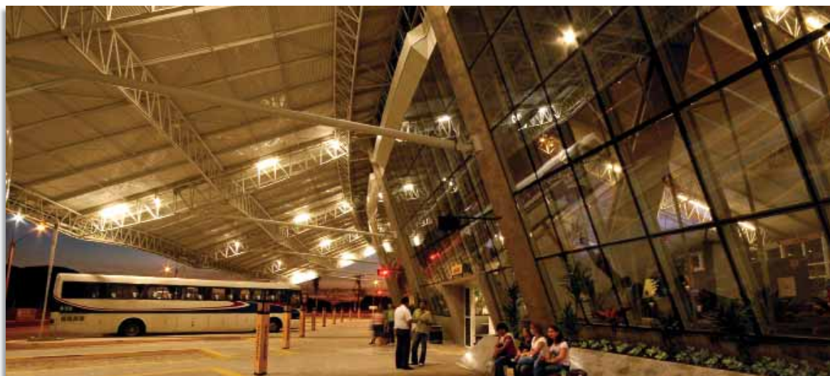
Área da plataforma, com cobertura em policarbonato e iluminadas com lâmpadas T5.
