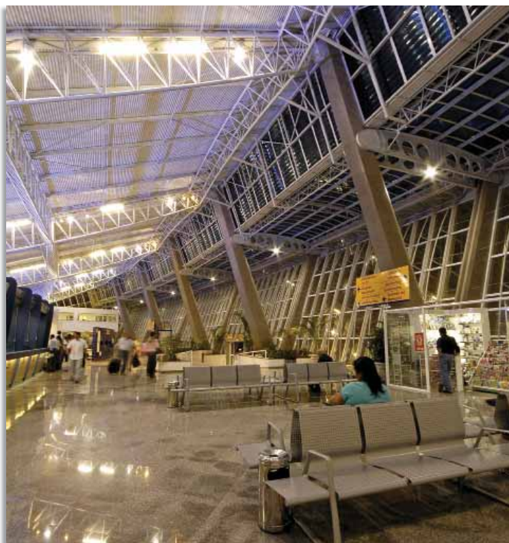
Área dos guichês iluminada com lâmpadas CDMR e T5 instaladas nas vigas entrelaçadas.
