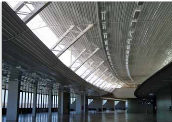
Terraço do aeroporto de Confins: geometria da clarabóia evita incidência solar direta no espaço interno.
