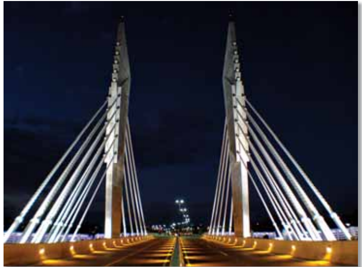
Nas pistas de rolagem, luz âmbar, a 3000K, proporciona conforto aos motoristas.
