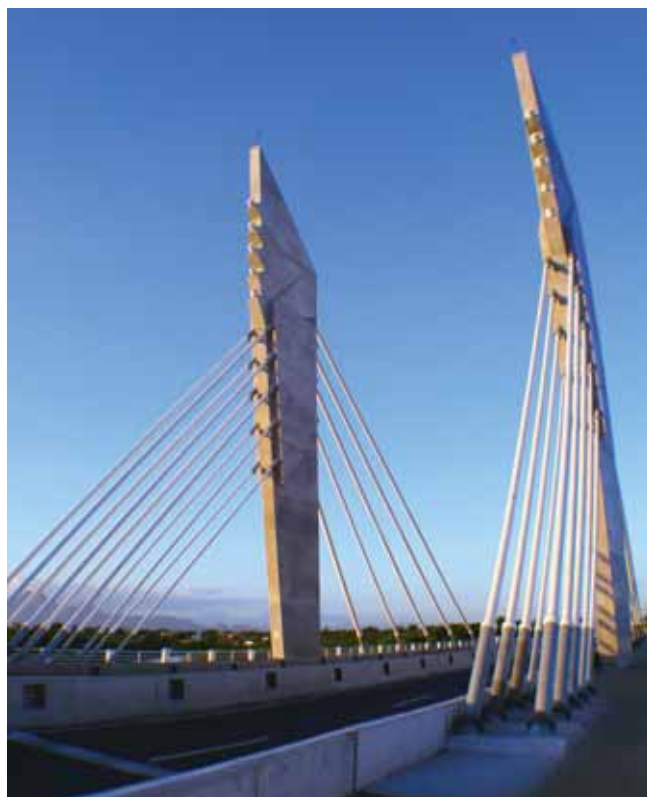
Vista diurna dos estais tensionados.
