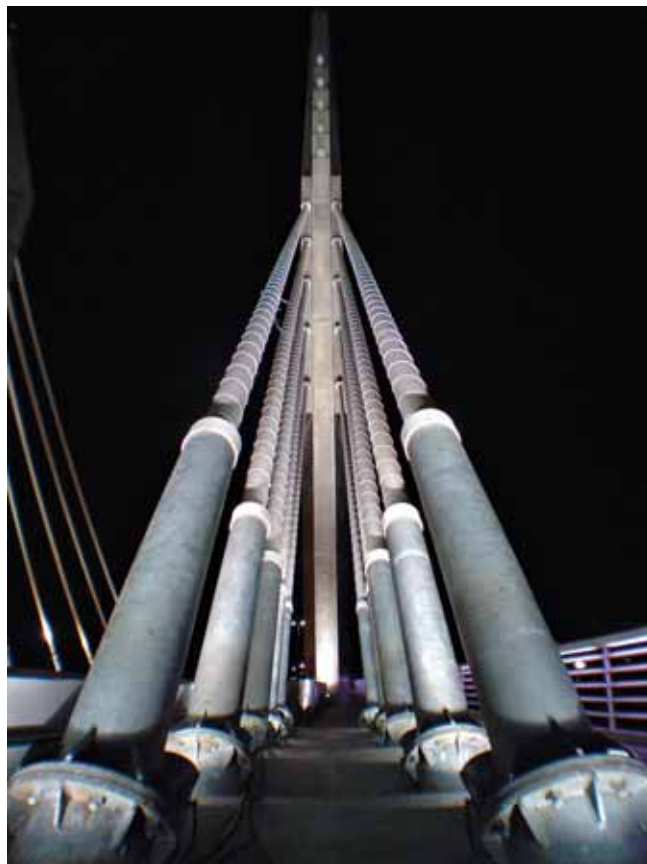
Iluminação dos estais: intensa nas bases e suaves no topo.
