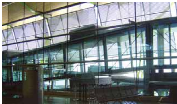
Solução construtiva que reduz o ofuscamento.
