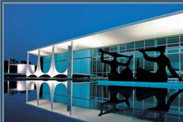
Palácio da Alvorada, em Brasília. Projeto luminotécnico de Peter Gasper / Peter Gasper Associados.
