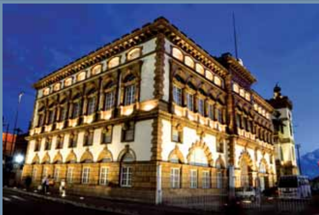
Alfândega de Manaus(AM). Projeto luminotécnico de Fabiano Xavier e Alain Maitre / Ateliê Lumière.
