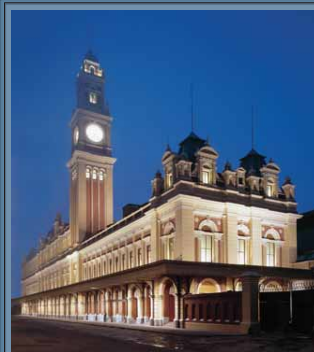
Estação da Luz, em São Paulo (SP). Projeto luminotécnico de Gilberto Franco e Carlos Fortes / Franco & Fortes Lighting Design.
