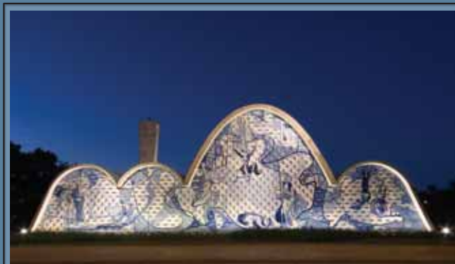
Igreja da Pampulha, em Belo Horizonte (MG). Projeto de iluminação de Mônica Lobo / LD Studio.
