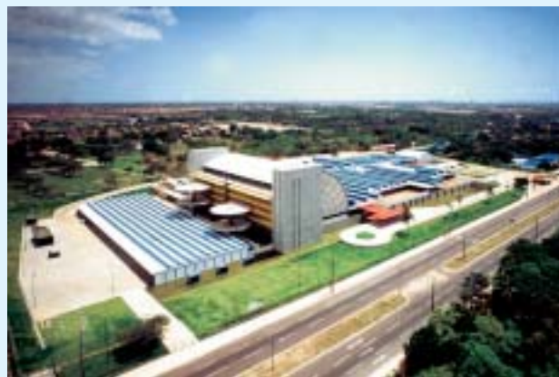
Hospital Rede Sarah Fortaleza - CE Arquitetura: João Filgueiras Lima - L&L&E
