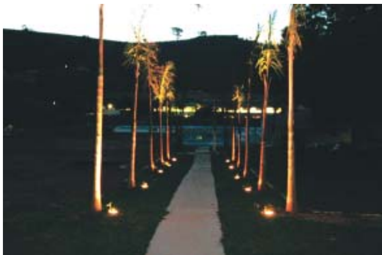
Luminárias de embutir direcionáveis com lâmpadas AR111 iluminam laterais do caminho.
