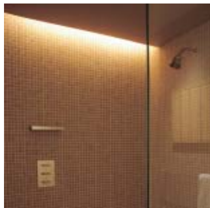
Área do chuveiro tem iluminação à prova de umidade.
