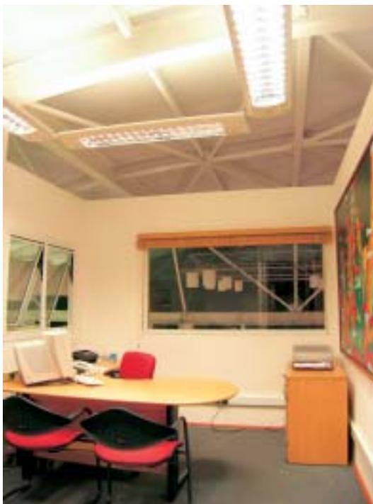
Pendentes diretos e indiretos, em que foram adaptadas cantoneiras metálicas para facilitar a fixação na cobertura, diminuíram a quantidade de cabos de aço.
