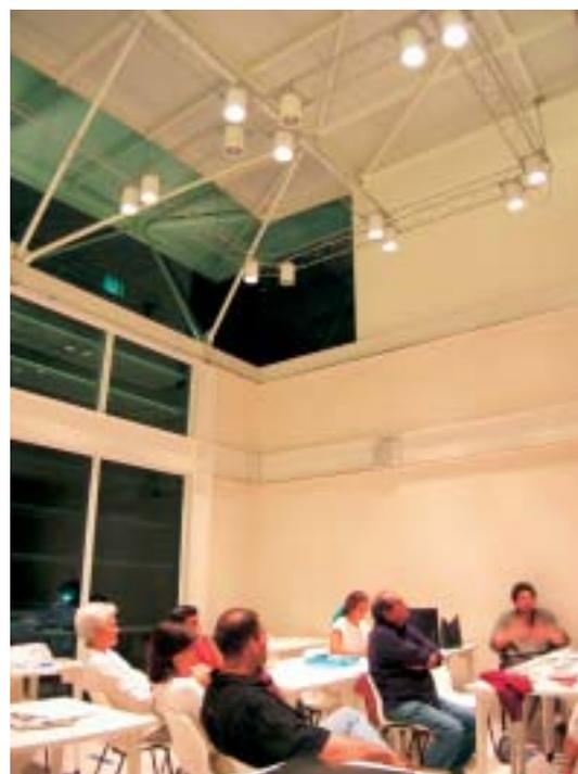
Estrutura espacial em que foram fixadas luminárias de fecho direto para iluminar o auditório. A solução minimiza os cabos de fixação e esconde os fios de alimentação, evitando interferência na transparência da obra.
