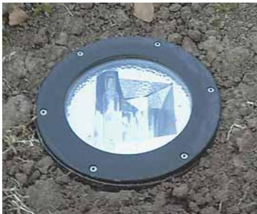
Luminária com ótica assimétrica, desenvolvida especialmente para o projeto.
