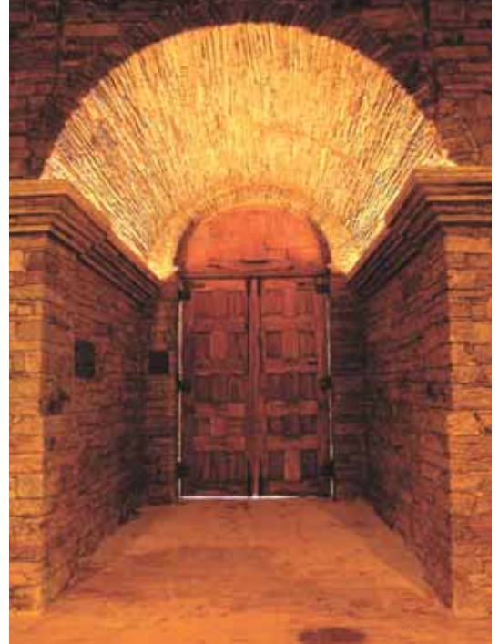
No pórtico de entrada, a iluminação foi feita de forma indireta, através de sancas existentes nas paredes laterais, onde foram utilizadas lâmpadas fluorescentes com temperatura de cor quente.
