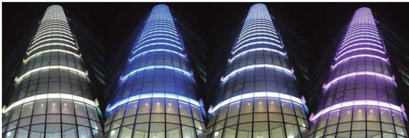
Foi utilizada uma tecnologia chamada Tricromia, desenvolvida no Brasil, com uso de lâmpadas fluorescentes, para possibilitar o recurso de dimerização e troca de cores.
