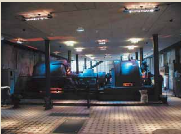
Hall de Turbina, Teatro em Duisburg, Alemanha Lighting designer: Graham Phoenix - Assistente: Melissa Stears
