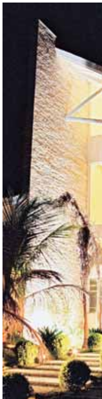
Parede Lateral Texturizada Detalhe
