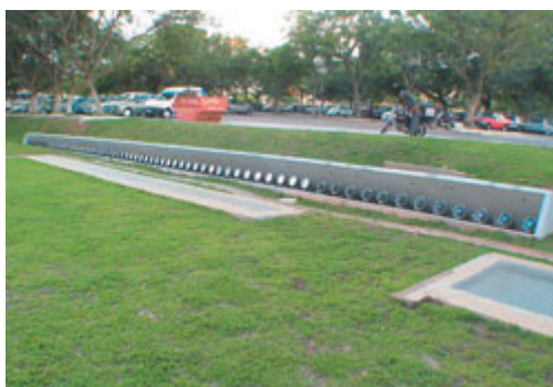
Foi colocada uma fileira de refletores de foco ultra-fechado numa espécie de trincheira, a 30m de distância do "olho".
