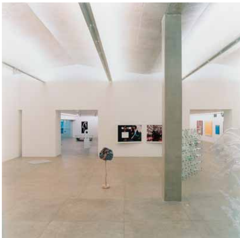
Museu MAC - SP Arq. Barbieri & Gorski Arquitetura Iluminação: Franco e Fortes Lighting Design Fluorescentes em calhas feitas sob medida.
